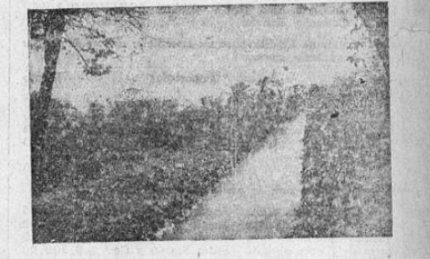
Canal de 500 litros por segundo de capacidad, construido bajo la dirección de STICA, para el riego de una finca en el Guanacaste. Más de 2000 manzanas han sido puestas bajo riego oportuno con la dirección de STICA.
